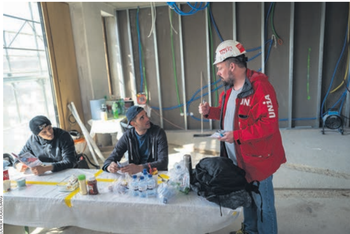
Tournée des chantiers à Genève, en mars 2022. Les syndicalistes d'Unia recueillent les revendications principales des travailleurs du second œuvre dans un sondage réalisé en perspective des négociations pour le renouvellement de la Convention romande.
