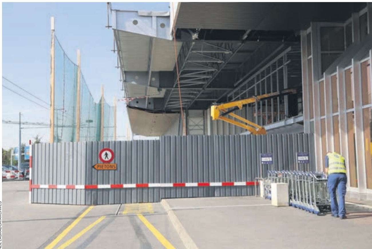
Le retour d'une partie des ouvriers dont l'entreprise avait été exclue du chantier du Tri Bagages de l'aéroport est une belle victoire syndicale pour Unia. Mais tout n'est pas réglé, et le syndicat restera vigilant face à la sous-traitance abusive.
