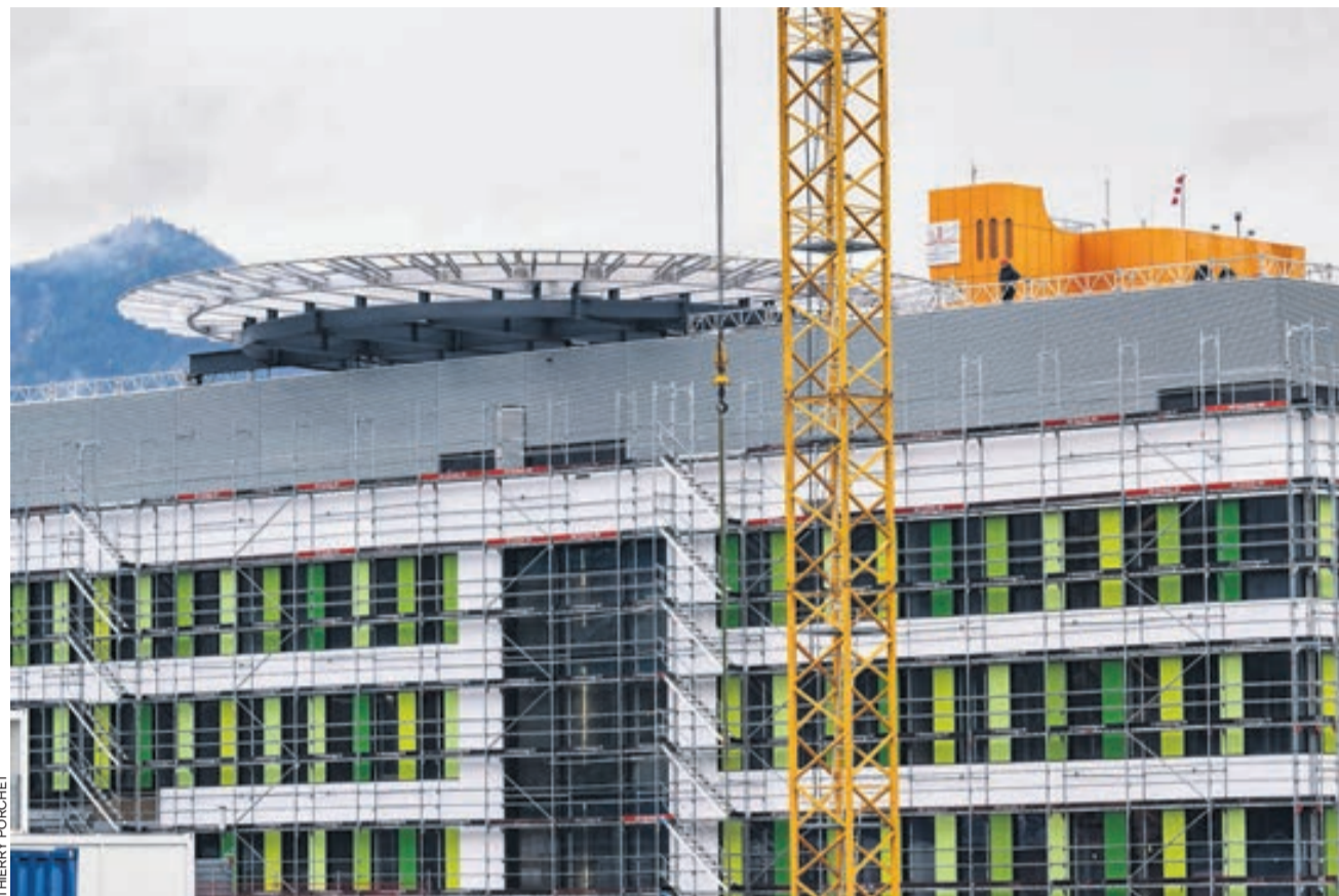
Les travailleurs intérimaires, venant de Pologne, de Slovaquie, de Lettonie et des Pays-Bas, étaient payés 14,98 euros l'heure pour construire l'héliport de l'hôpital de Sion. La CCT de la branche prévoit le double. Leurs frais de repas étaient également réduits drastiquement.
