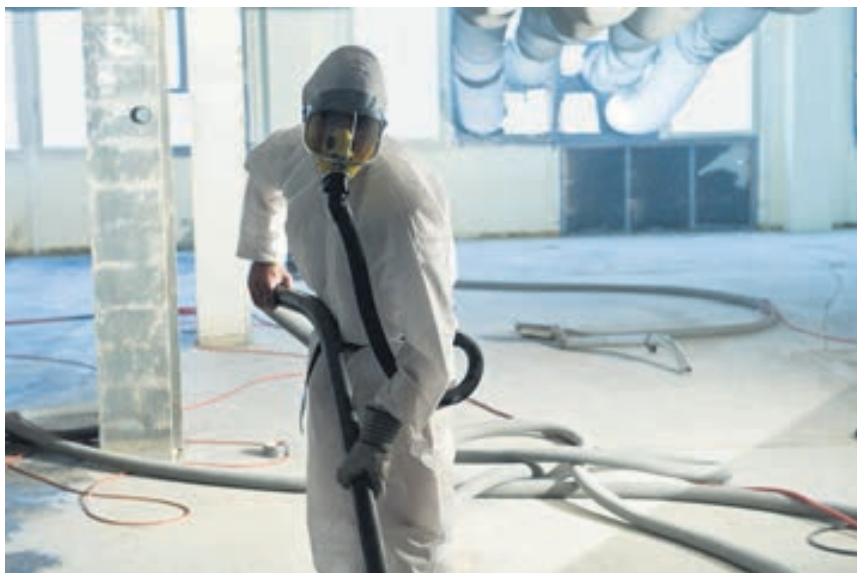
Opération de désamiantage. La reconnaissance du caractère meurtrier de la fibre a pris beaucoup de temps malgré les avertissements répétés des hygiénistes du travail.
