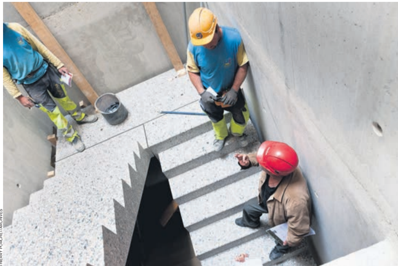
Neuchâtel se dote d'une loi pionnière en Suisse! Avec des protections exemplaires des salariés, notamment en matière de travaux pendant la canicule ou les intempéries, ou encore d'égalité salariale et de limitation du travail temporaire.
