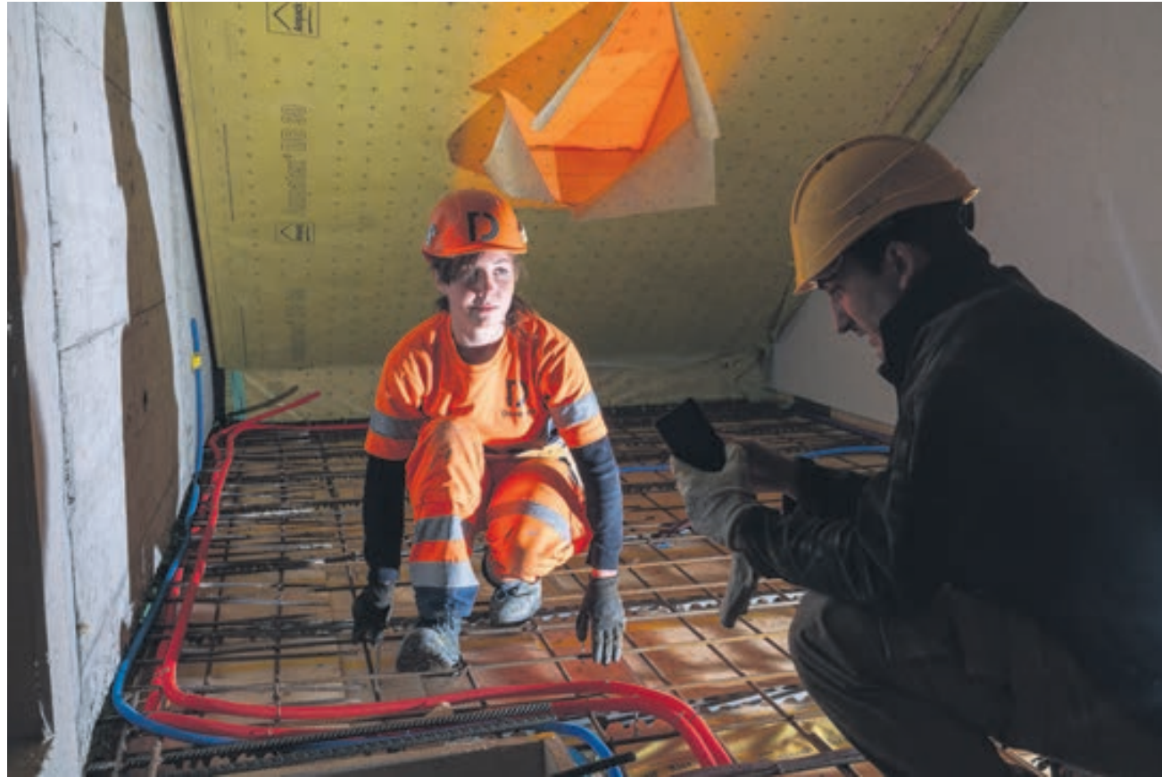
Dernières finitions d'Elise Locatelli, coachée par le chef de chantier.
