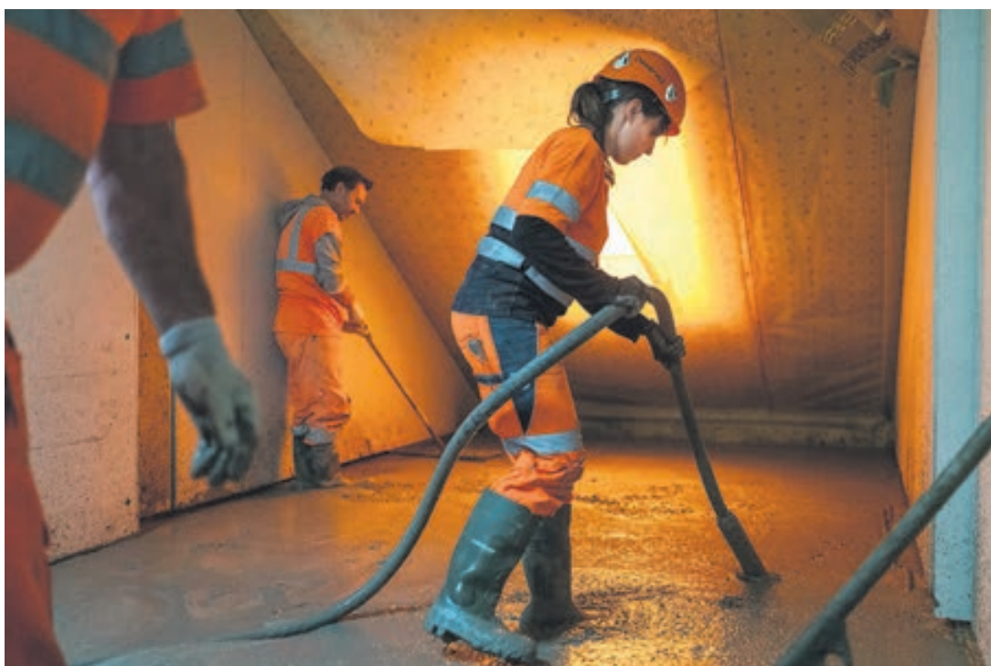
La jeune femme «vibre le béton» avec une «aiguille» qui, comme son nom ne l'indique pas, est passablement lourde.
