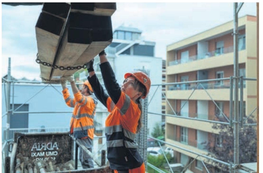
Avant le bétonnage de la dernière dalle, les pièces d'étais sont récupérées par les airs, puis installées.
