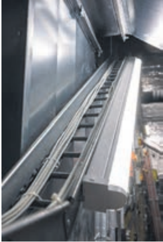
Entre autres créations, l'électricien pose des chemins de câbles et des luminaires.
