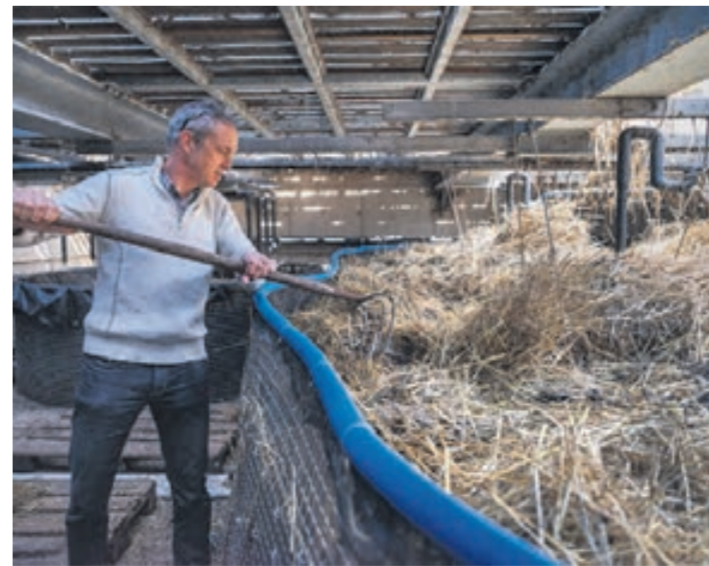
Benoît Molineaux, secrétaire général de la coopérative Equilibre, manie la fourche pour montrer les vers de terre à l'œuvre dans la station d'épuration expérimentale de l'immeuble de Soubeyran.
