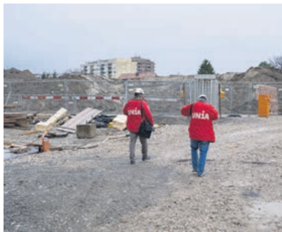
Les deux permanents d'Unia Genève dans l'immense chantier que sont les Communaux d'Ambilly.
