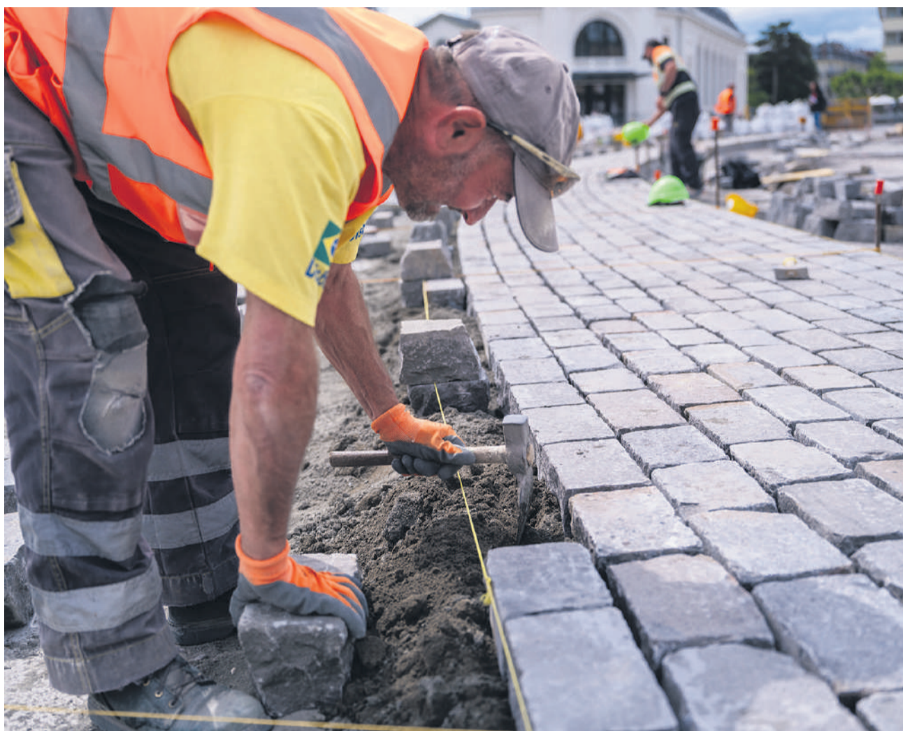
Contrairement aux pavés en béton, les blocs en pierre, du grès dans ce cas, sont tous différents. Sens des proportions et bonne représentation spatiale guident les gestes des travailleurs.
