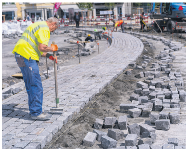
Roland Verboux, le patron de l'entreprise l'Artisan paveur, utilise une dame à main afin d'égaliser les pierres.
