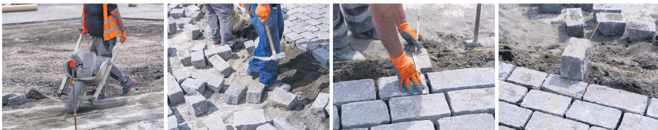
Un travail harassant. L'équipe formée de quatre travailleurs gère chaque jour jusqu'à 10 tonnes de pierres, 4 mètres cubes de mortier et pose en moyenne 15 à 20 mètres carrés de pavés.
