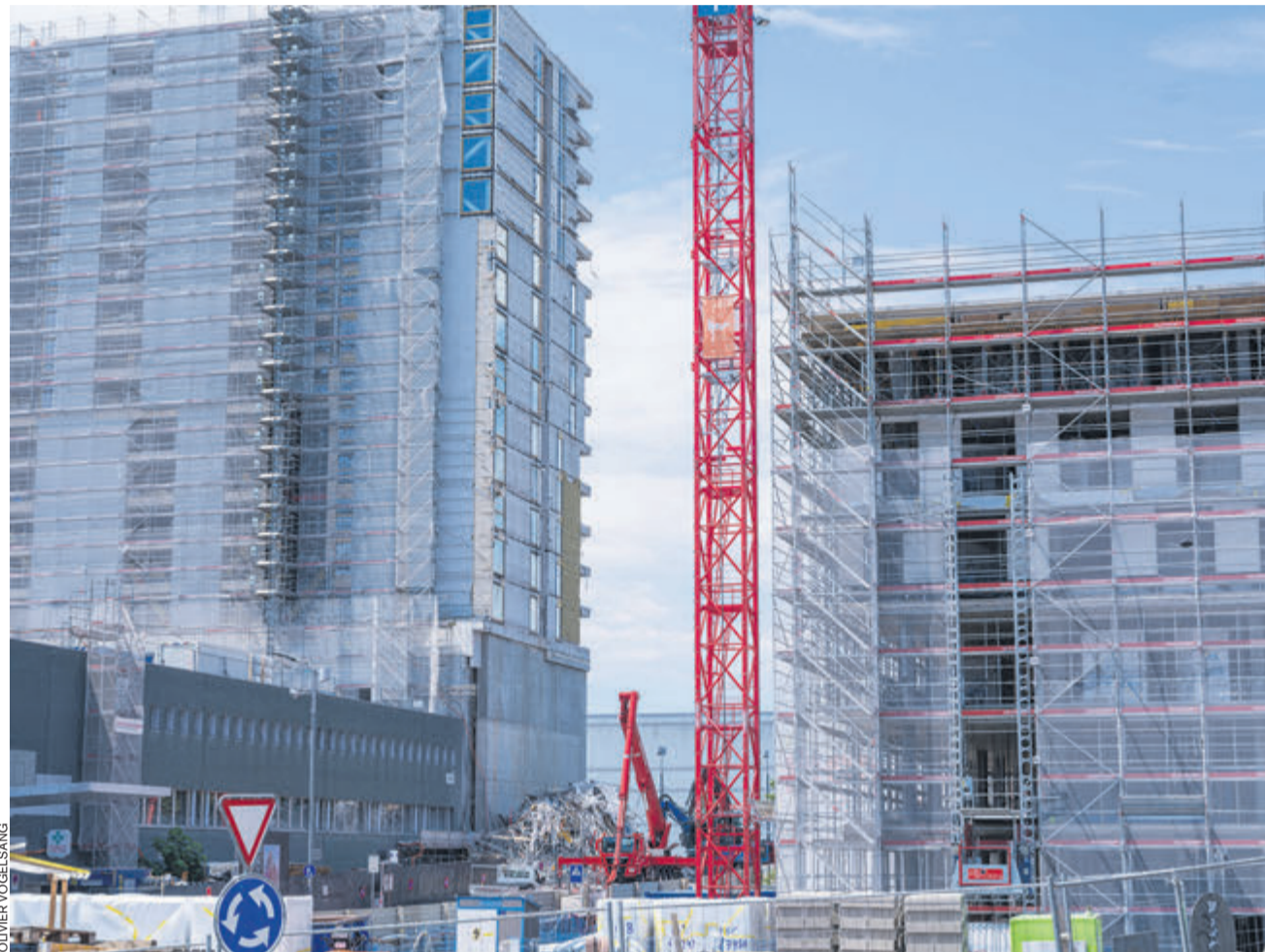
Dix mois après l'effondrement de l'échafaudage de la tour Malley Phare, près de Lausanne, les causes du drame qui avait fait trois morts ne sont toujours pas claires.
