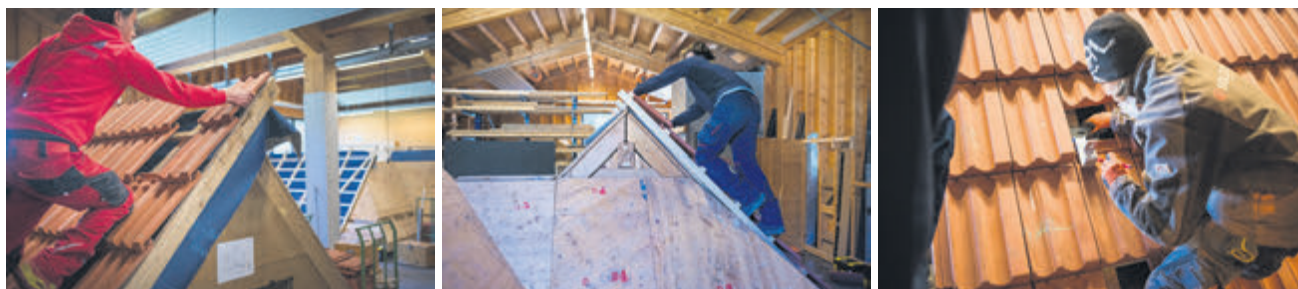
Des maquettes ont été créées pour permettre aux apprentis de réaliser une toiture réelle, en pente et plate, avec toutefois des panneaux plus petits.
