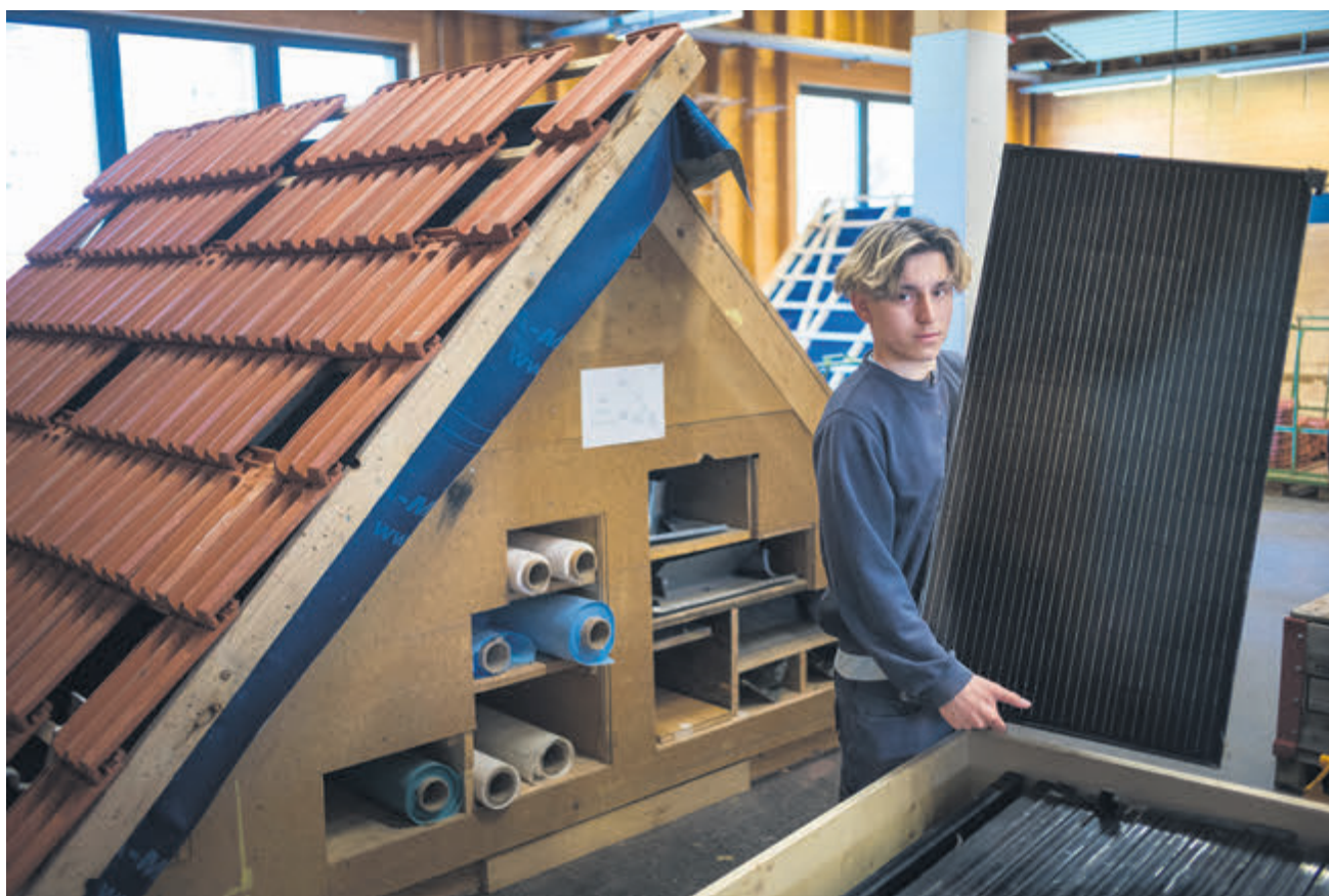
Des maquettes ont été créées pour permettre aux apprentis de réaliser une toiture réelle, en pente et plate, avec toutefois des panneaux plus petits.
