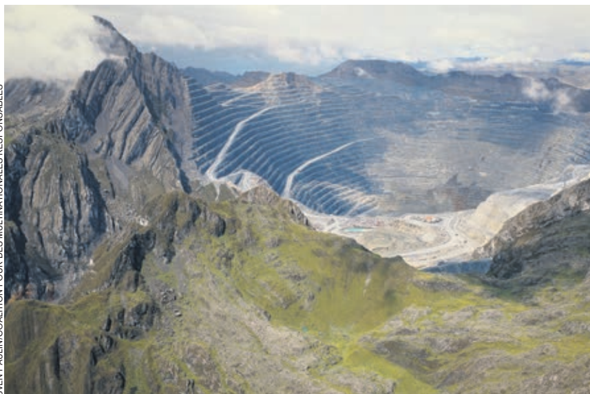
La mine de cuivre et de zinc d'Antamina dans les Andes péruviennes est reliée au port de Huarney par un pipeline de 300 kilomètres.
