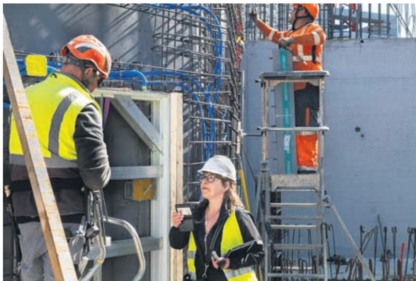
Genève et le Tessin sont les deux cantons les plus zélés dans le contrôle des entreprises. Ici, une inspectrice du Bureau de contrôle des chantiers à l'œuvre à Genève.
