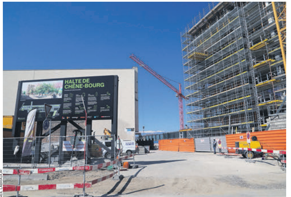
Il n'y aura pas de travail les samedis jusqu'en juillet sur le chantier du parking de la gare de Chêne-Bourg, malgré les souhaits de l'Etat.
