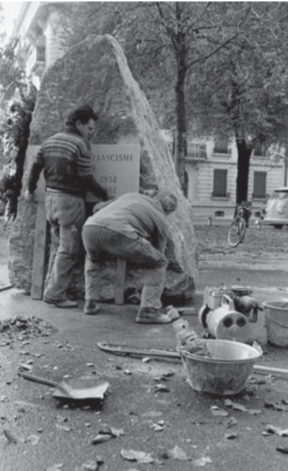
La Pierre, peu après sa pose, en novembre 1982.
