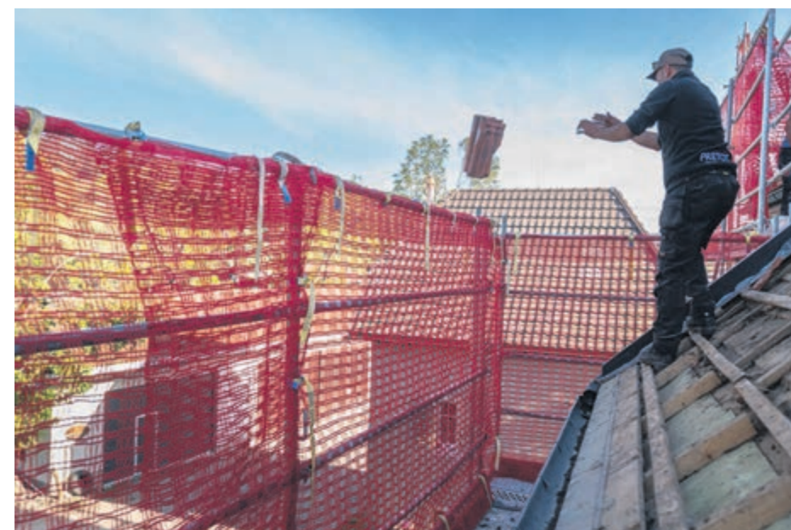
Les tuiles endommagées sont lancées dans une benne.
