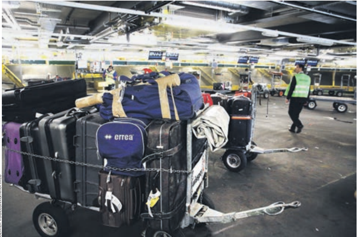
Les installations pour le tri des bagages sont remises à jour au sein de l'aéroport de Genève. Un contrôle de ce gros chantier a révélé une sous-traitance en cascade, avec en bout de course des travailleurs, venus d'Italie et de Roumanie, exploités et sous-payés.
