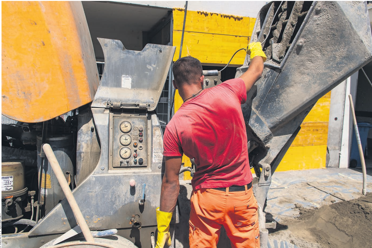
La canicule additionnée à la pénibilité des travaux menace la santé des ouvriers.
