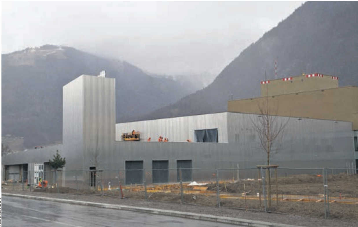
Le gouvernement propose d’abandonner la règle du lieu d’exécution, définissant notamment les conditions de travail et de salaires, au profit du lieu de provenance des entreprises soumissionnaires (photo: chantier de l’Hôpital Riviera-Chablais à Rennaz).
